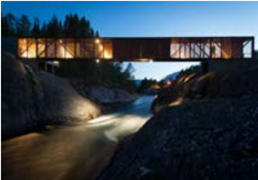
Ryfylke. © Jarle Wæhler / Statens vegvesen
